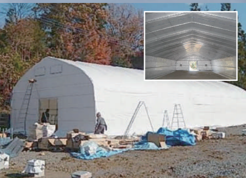
ビニールハウスの内側に施工
